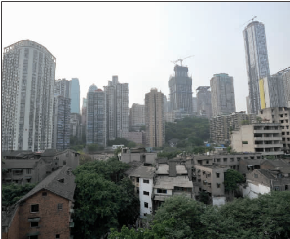
渝中区储奇门,随着城市建设迅速发展,高楼拔地而起,火灾隐患也越发明显 本组图片均由本报记者 胡健 摄
